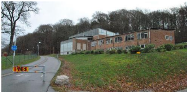
Byggnad nummer 12 (maskinbyggnad/panncentral) samt tillhörande verkstadsdel (nu rivet). Foto: SBK, 2014
